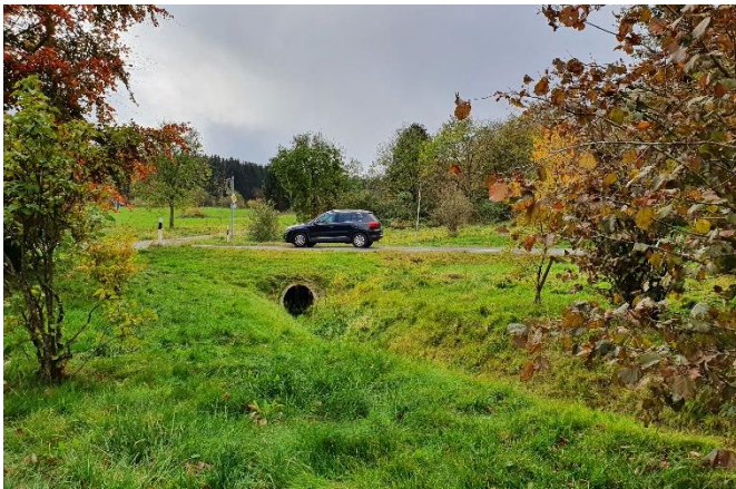
Auslass des Dorfgrabens unter der L 27
