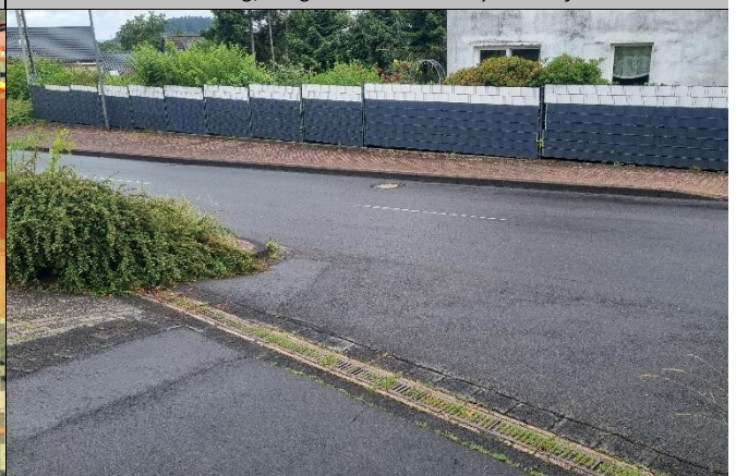
Einlassrinne im Weg, angrenzend zur Leyenstraße
