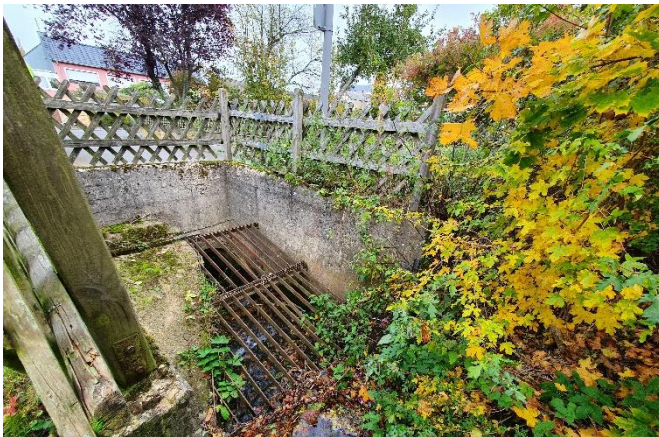
Kirchweilerbach: Einlassbauwerk an Hauptstraße
