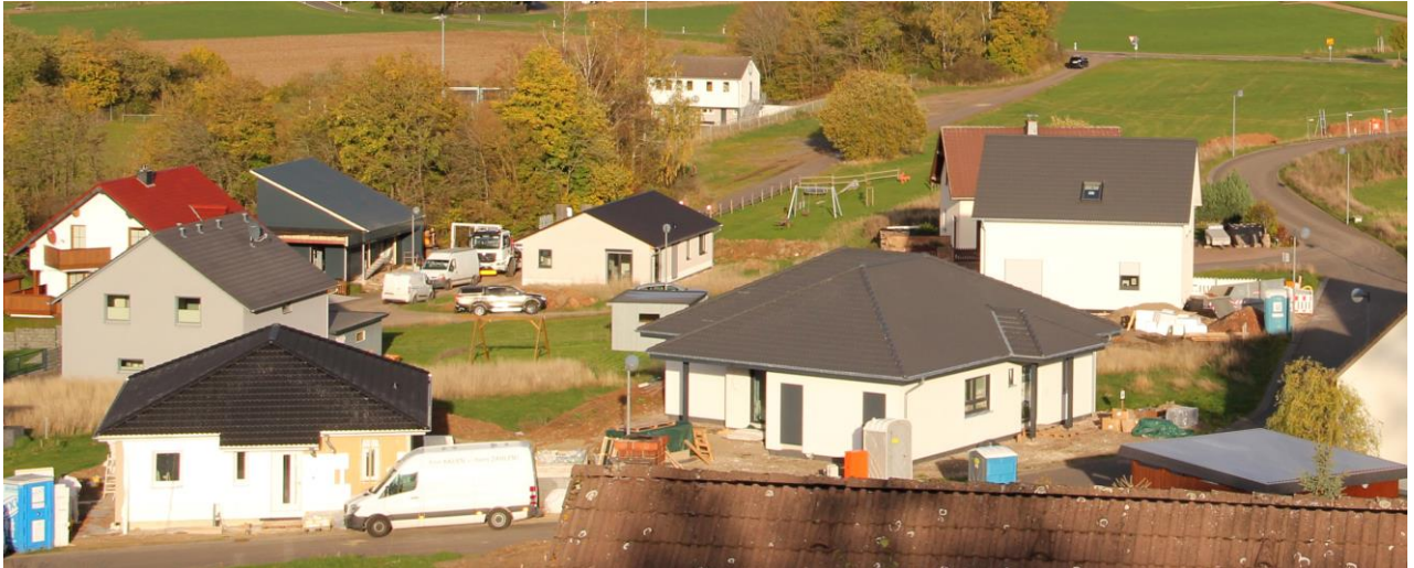
Das Foto zeigt einige der Neubauten und im Hintergrund den naheliegenden Kinderspielplatz.
